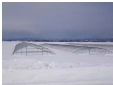
図-9 ビニールハウスの被害
