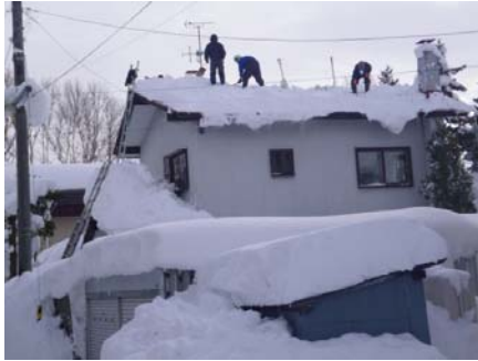
図-6 屋根の雪下ろし
