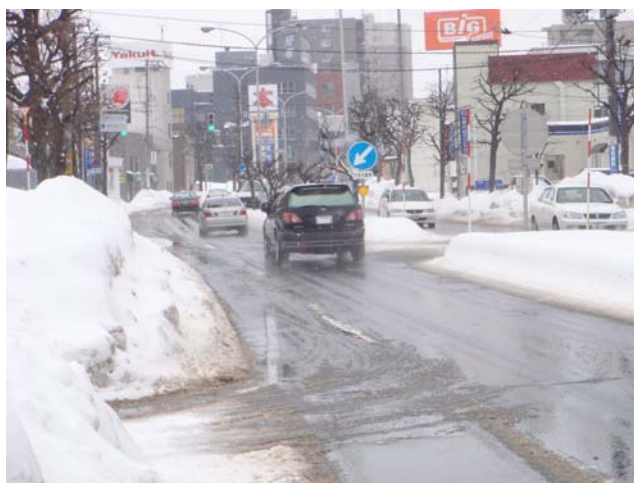
写真-1 冬期の道路有効幅員
