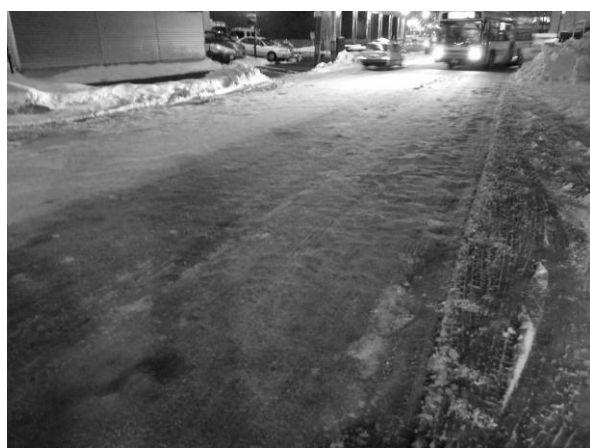
図-9 2/24夜の路面状況(左：実験区間，右：一般国道12号の小さな珠)
