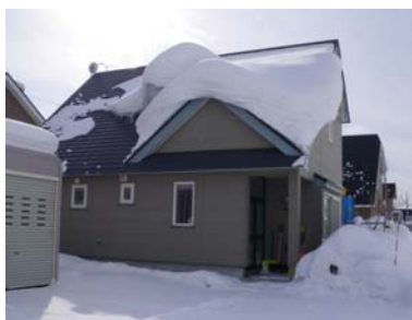
写真-2 落雪屋根の落雪障害
