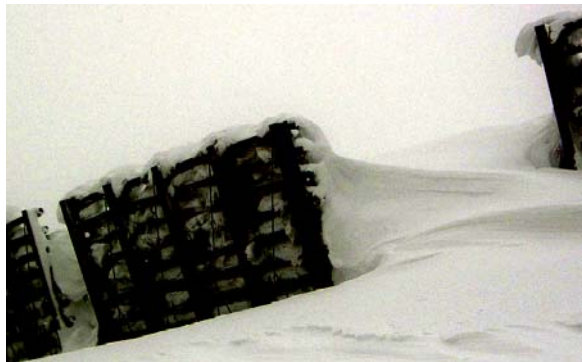
写真-3 巻だれと繋がった風上側の吹きだまり
