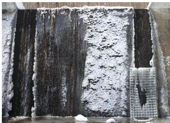
図 4 2010 年 3 月 28 日 10 時（1 号床固工）
