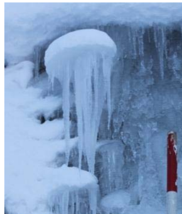
図14 2011年1月11日(図4の ダム堤体中央上部に出来た、大き く成長した、典型的なクラゲ氷、 頭部直径約25cm)
