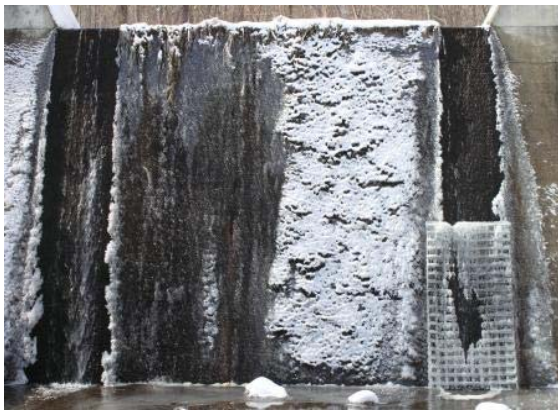
図 4 2010 年 3 月 28 日 10 時（1 号床固工）
