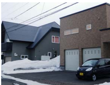
写真-1 落雪屋根と無落雪屋根
