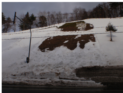
図-8 ⑦むかわ町国道 274 号沿い 穂別ダムから東に約 1.5km GPS 標高 235m, N42° 53' 10.79", E142° 12' 10.95"
