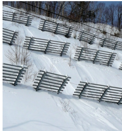
写真5 雪崩柵を抜けるスラブ
