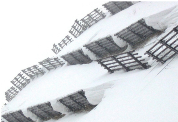
写真6 メッシュを張った雪崩柵に止められた雪, 年間を通すとスラブの量は無視できない
