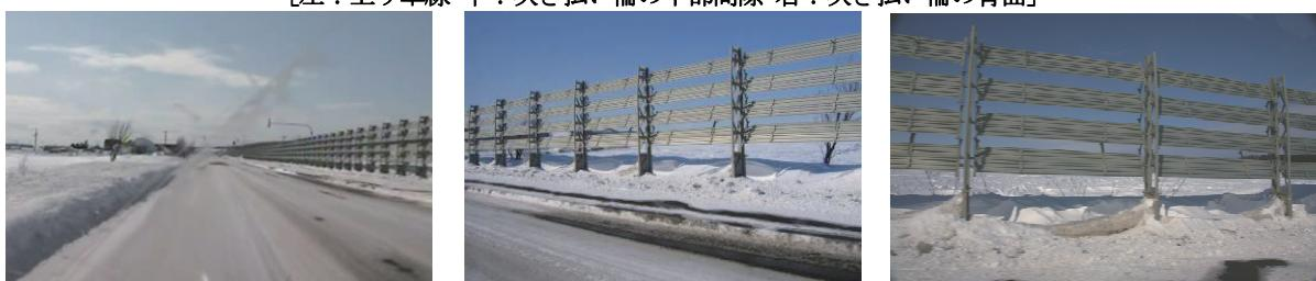
図 8 吹き払い柵の設置された区間の吹きだまり状況 (KP43-44.5付近)
