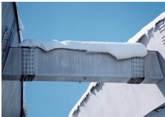
写真3 橋梁部材から破断した雪庇
