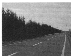
写真1 調査箇所(全景)
