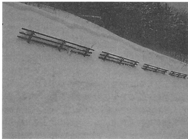
写真2 雪崩予防柵をすり抜けた雪崩
