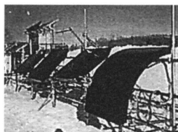
写真-3 パネル配置状況
