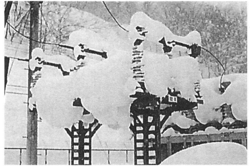
図2 72kV しや断器の冠雪状況(融雪ヒータ無) 図3 72kV 断路器の冠雪状況(融雪ヒータ無)
