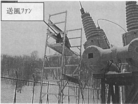
図8 送風ファンの設置状況
