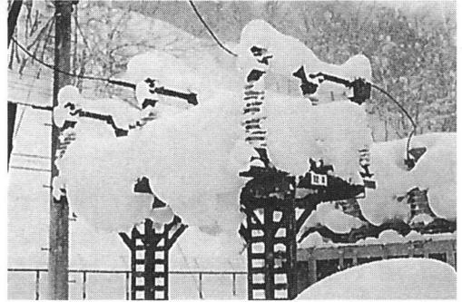
図2 72kV しゃ断器の冠雪状況 (融雪ヒータ無)
