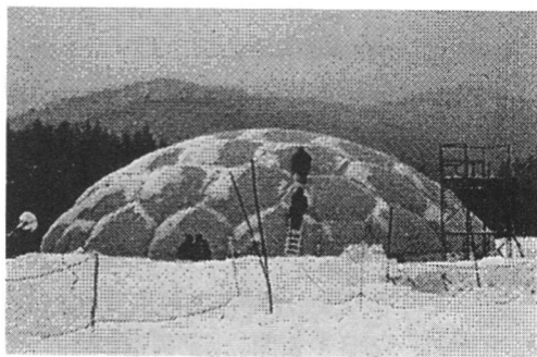
図-8 型枠空気膜ドーム
