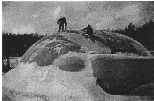
図-2 型枠空気膜
