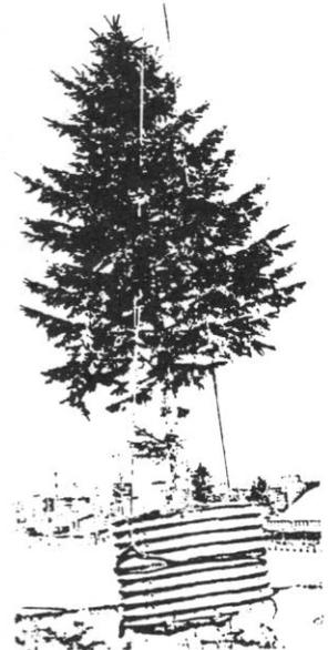
写真-2 凍土方式による成木移植(北彩都あさひかわ, 1998.2.21)
