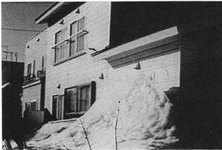
写真1 軒下堆積雪による採光障害
