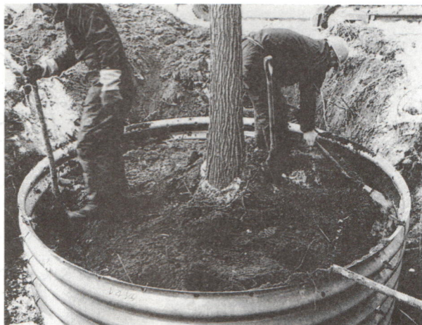
写真-3 隙間への土の充填と注水
