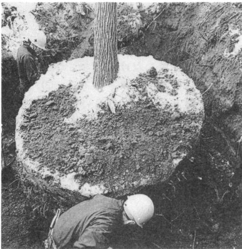
写真－1 根系の機械による掘取り
