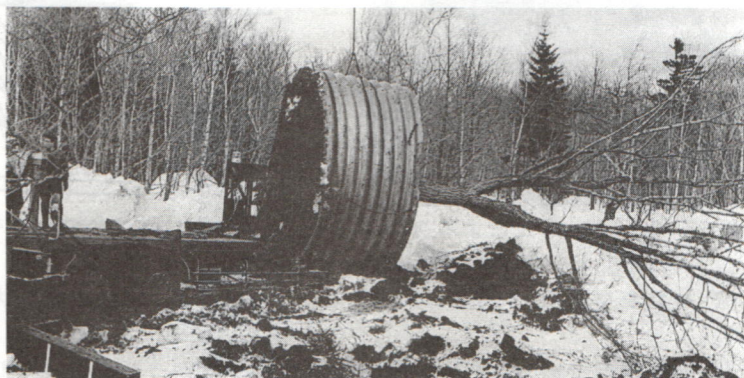
写真-4 凍結した根鉢の吊り上げとトラックへの積み込み
