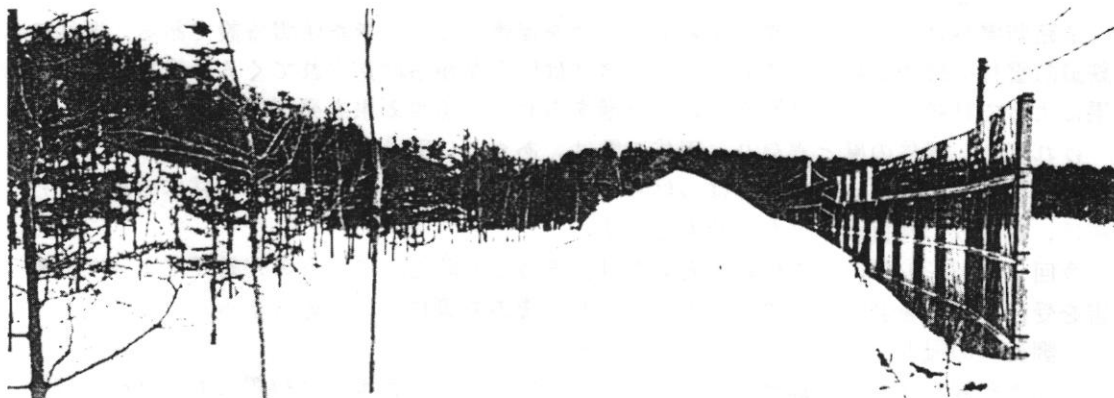
写真-2 防雪柵の風下側に大雪丘が形成され、樹木は埋没していた(右手が風上側)
