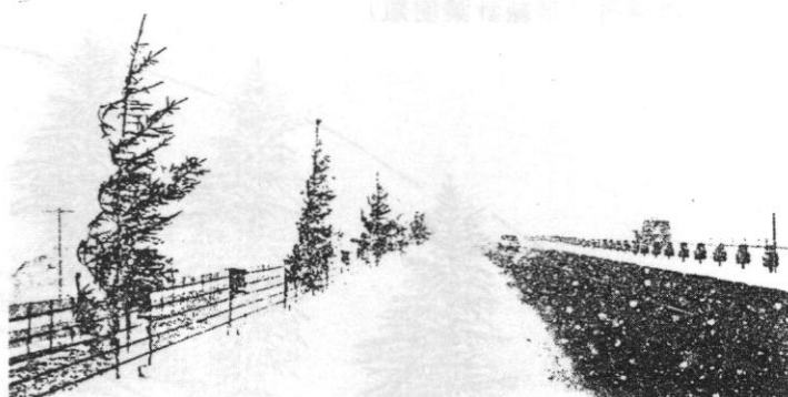
図－5 25m間隔で設置された視線誘導樹と自発光ポール
