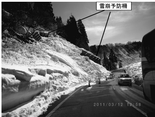
図 8 雪崩予防柵の上部斜面から発生した雪崩が道路を埋没（新潟県十日町市）。
