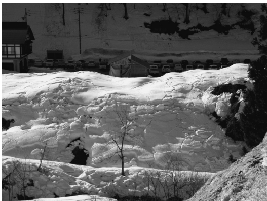
図 5 地震によって発生した格子状のクラック（長野県栄村）.
