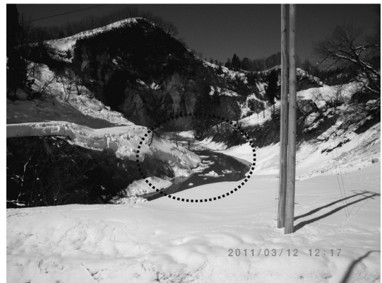
図 10 地震による雪崩によってダムアップした河川（新潟県十日町市：波海川）。
