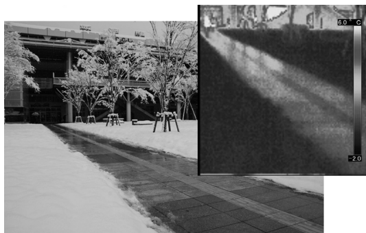
図3 路面融雪状況
