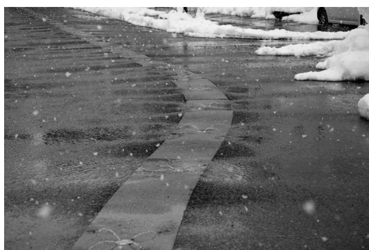
図 1 消雪パイプ散水状況
