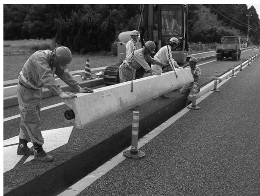
図 2 メンテナンス対応型消雪パイプブロック設置
