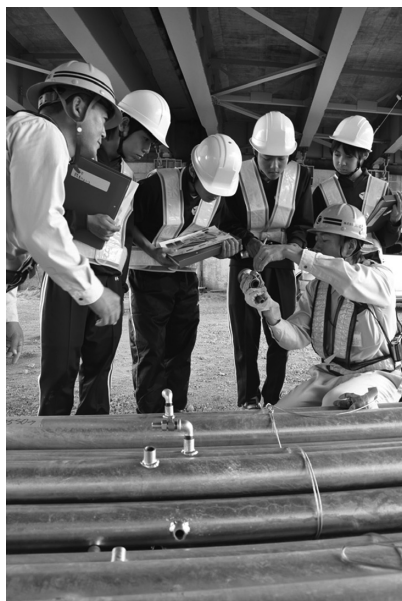
図 10 職場体験で消雪パイプ工事を体験
