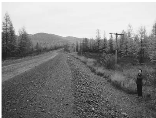
図 13 ティンカ街道の防雪対策構造。
