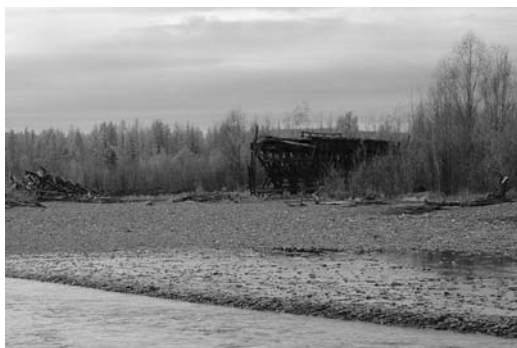
図 10 崩れ落ちた橋。右に黒い壊れた橋の残骸が見える。
