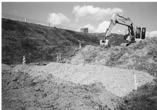
図 1 道路防雪林づくりにおける地拵え (高規格道路・帯広～広尾間; 2007 年 10 月撮影)。 低湿地に排水溝を掘る→客土し、転圧する→砂利を載せ、排水層をつくる (全面砂利暗渠)→根張り用の客土をする (転圧を避ける)。 根張り空間が、深く広いほど、透水性・通気性が良好なほど、植栽木の成長が旺盛であり、早期に防雪機能が発現する。
