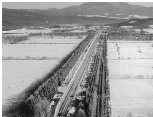
図 2 国道 40 号中川町国府の道路防雪林の偉容 (写真の上が旭川方面; 2008 年 2 月撮影, 荒井建設(株)提供)。
