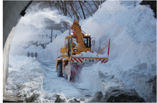
写真 2 雪崩で埋まったトンネル抗口を開通中の新潟県派遣ロータリー除雪車。(2 月 23 日 和泉 薫撮影)
