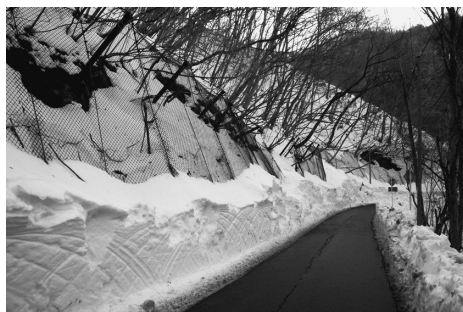
写真 8 落石防護ネット設置道路への雪崩の流下。(左) 雪崩の雪がネットをすり抜けた事例(埼玉県横瀬町)。(右) ネットが雪を捕捉し流出を抑えた事例(山梨県道志村)。(2 月 22・23 日 和泉 薫撮影)
