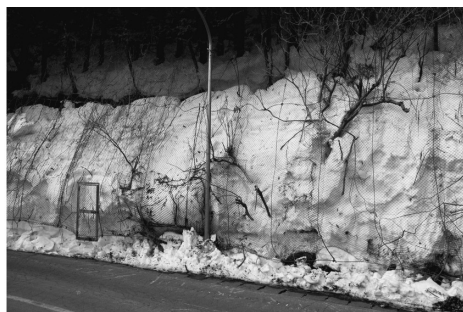
写真 8 落石防護ネット設置道路への雪崩の流下。(左) 雪崩の雪がネットをすり抜けた事例(埼玉県横瀬町)。(右) ネットが雪を捕捉し流出を抑えた事例(山梨県道志村)。(2 月 22・23 日 和泉 薫撮影)
