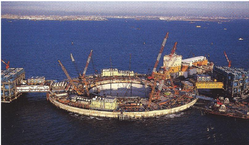
写真 3 空中から見た内径 98m の川崎人工島 (現 風の塔) の上部. この下部から, シールド機 (4 基) が凍土防護壁により海底地盤へ発進した.
