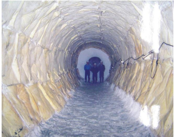
写真 2 円筒型凍土壁によるトンネル-立坑間の接続防護.
