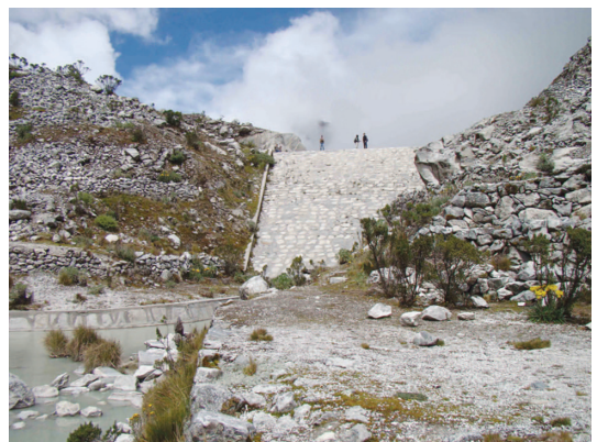
写真 4 Llaca 湖の人工堰堤（湖側より）
