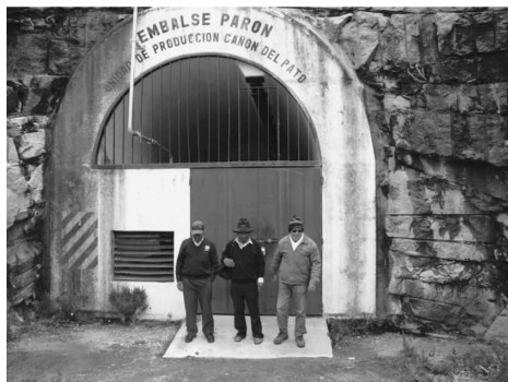
写真 7 ペルー Blanca 山脈の Paron 湖の トンネルの調整室の入り口
