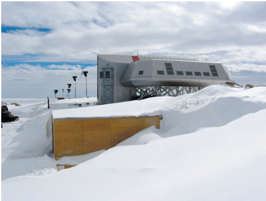
写真 1 建設中の Princess Elisabeth Station (PES)。基地は氷床から数 m 露出した露岩に高床式で建てられている。卓越風向は写真右から左。露岩の風下には車両倉庫(木材の壁が露出)。後方に見えるのは露岩に沿って設置された風力発電用の風車。
