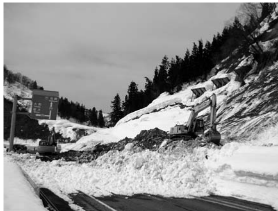
写真 5 十日町と旧堀之内町を結ぶ国道 252 号線を塞いだ全層雪崩（町田敬氏撮影，2005 年 2 月 18 日撮影）。
