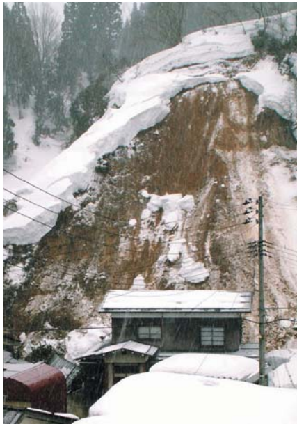
写真 2 地震で傷んだ斜面で起きた雪崩 （小千谷市西吉谷，2005 年 3 月 19 日撮影）。
