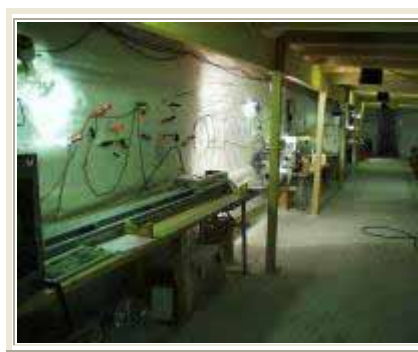
写真 4. NGRIP サイエンストレンチ建設4年後の屋根補強.
