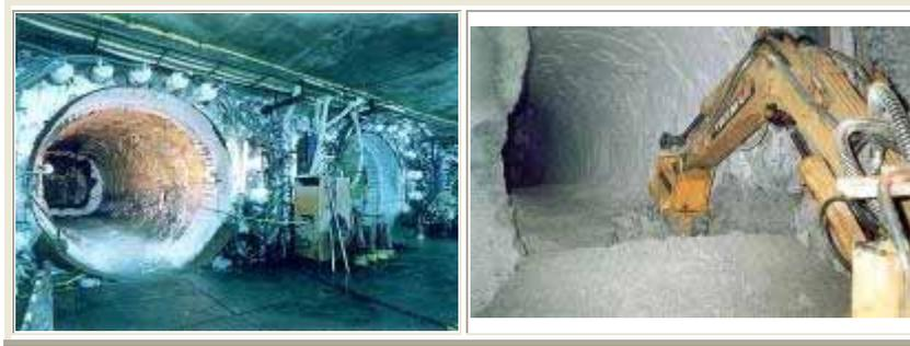
写真 1. 直径 3.5m の凍土トンネルの入り口。トンネル周囲に水平連結管の頭部が見える。
