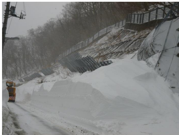
写真-5 地点①雪崩発生後の状況 (撮影：平成26年2月16日)
