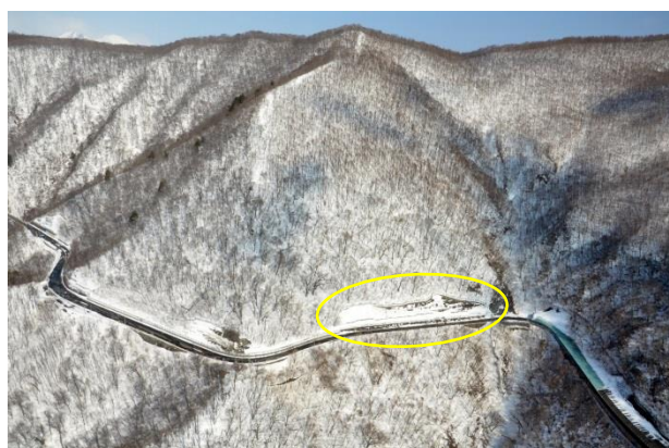
写真-6 地点①雪崩発生箇所空中写真 (撮影：平成26年2月20日)
