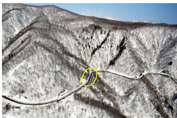
写真-4 地点③雪崩発生箇所空中写真 (撮影：平成26年2月20日)
