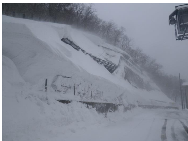
写真-2 地点①雪崩発生後の状況 (撮影：平成26年2月17日)
