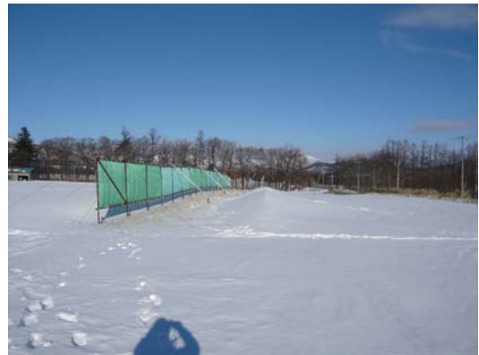
図1 野外観測の調査対象とした防雪柵（北海道上川郡新得町）
