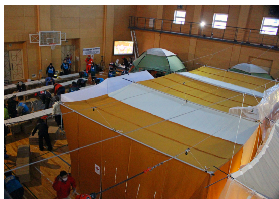
図1 シェルターAの懸垂部
