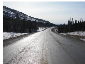
図-5 再凍結路面
